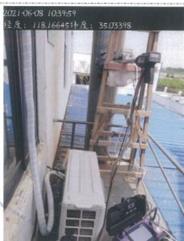
图 2: 沼气蒸汽锅炉燃烧废气出口现场采样
